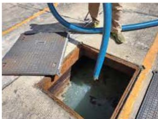
การสูบน้ำทิ้งระบบบำบัดน้ำเสียส่วนเกิน
